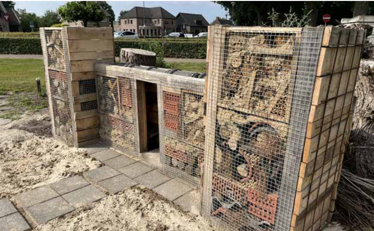
Bijenburgt in aanbouw
