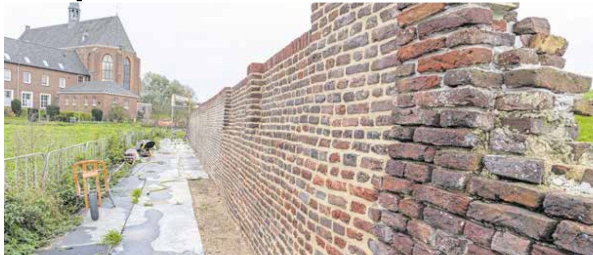
De kloostermuur is deels al onder handen genomen.
