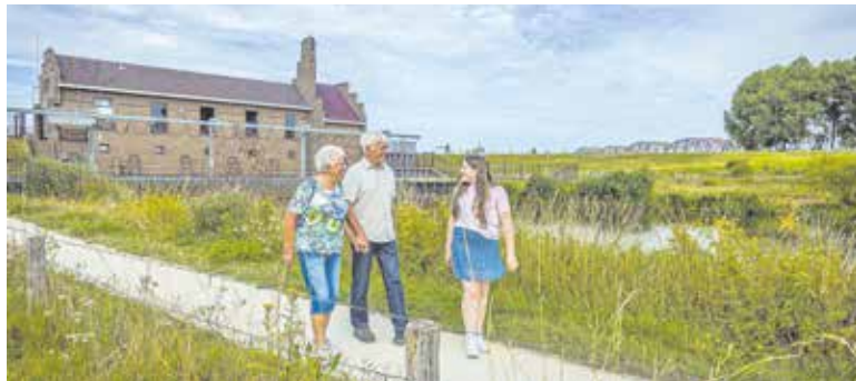
Gemaal van Sasse.
