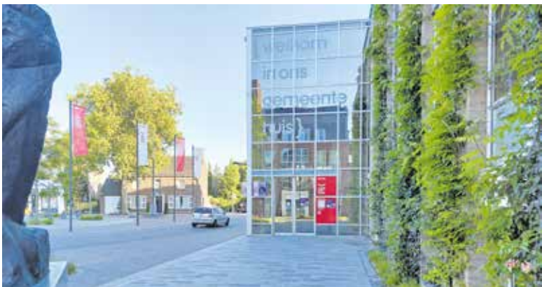
Het leegstaande voormalige gemeentehuis in Cuijk.
