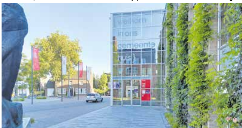
Het leegstaande voormalige gemeentehuis in Cuijk.
