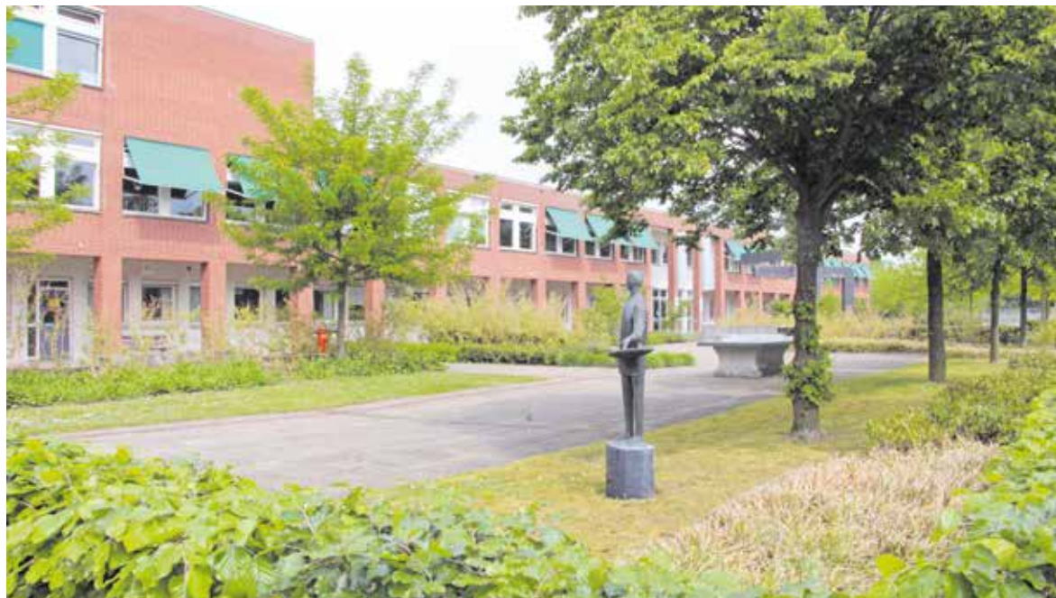
De gemeente heeft de toekomst van het gebouw in onderzoek.
