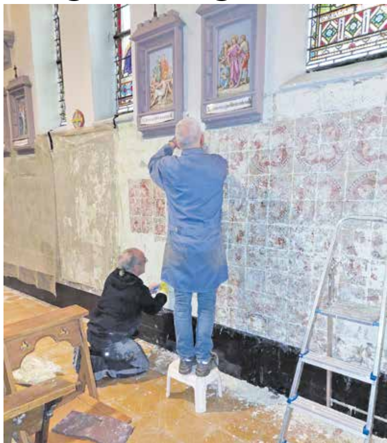
Het afhalen van de verflagen.
