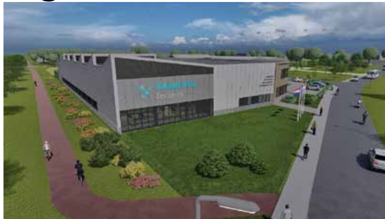
Nieuwbouw van Vakopleiding Techniek op Homburgterrein.
