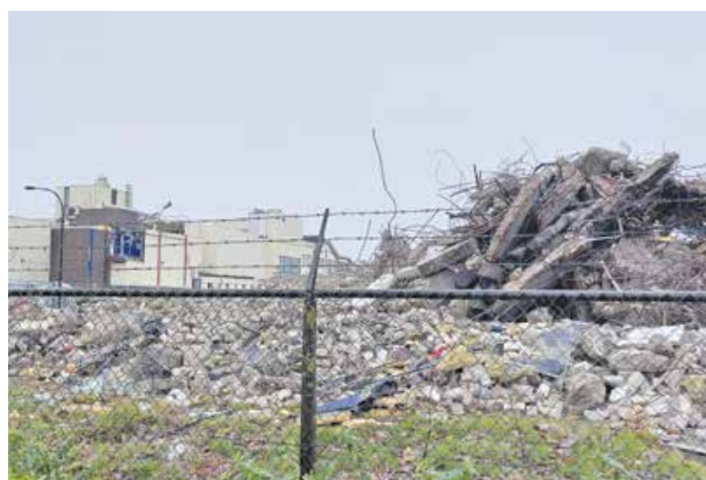
De sloop van het westelijk deel van de oude fabriek.
